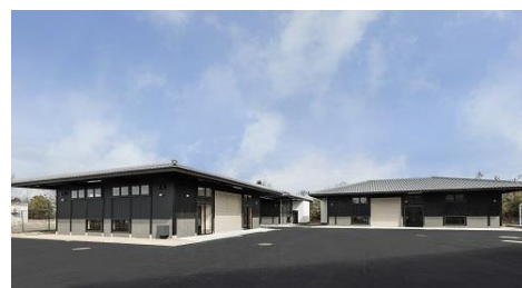
新たに建設された実験棟
