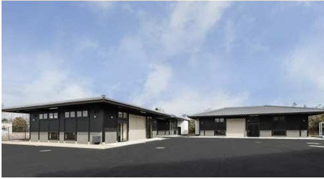
新たに建設された実験棟 3 棟
