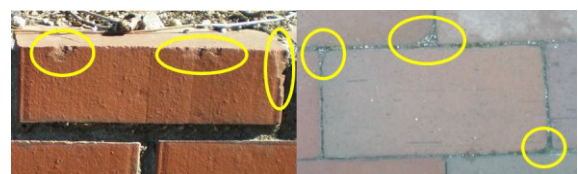
図2 施工済みれんがの縁・角部の状態(15年前後経過、左:花壇、右:歩道)
